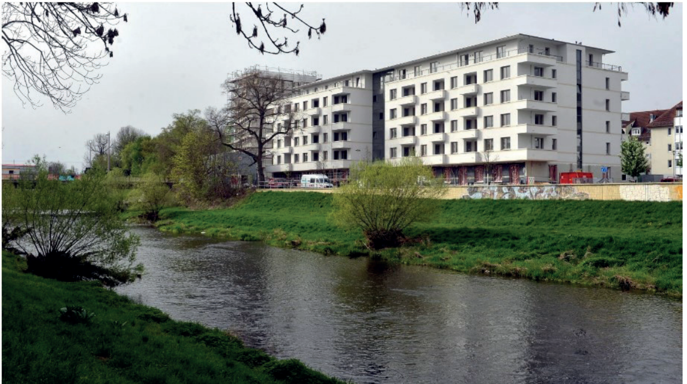
Außenansicht Neubau für altersgerechtes Wohnen im Heinrichs-Quartier an der Weißen Elster
